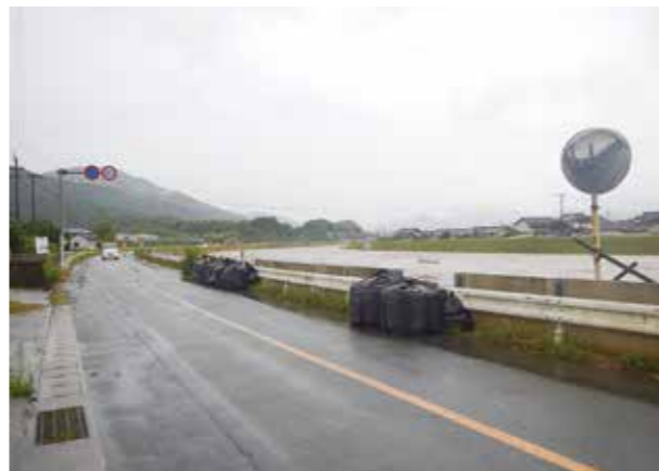
◀ 大型土のうを緊急設置(梅田)
