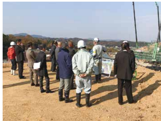
▲成光地区に建設中の汚泥再生処理施設建設現場を8名（次谷・丹村・毛利・奥永・佐々木・永原・坂本・松下議員）が見学。工事の概要や進捗状況などの説明を受けました。
