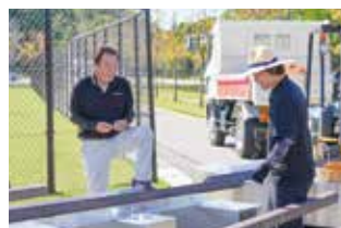
▲設置作業をしている様子
