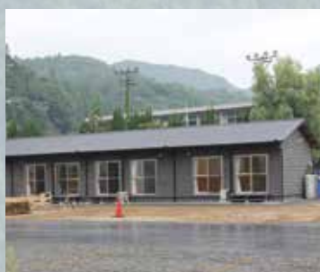
▲小学校のグラウンドで早急に建設されている仮設住宅(8月14日東峰村)
