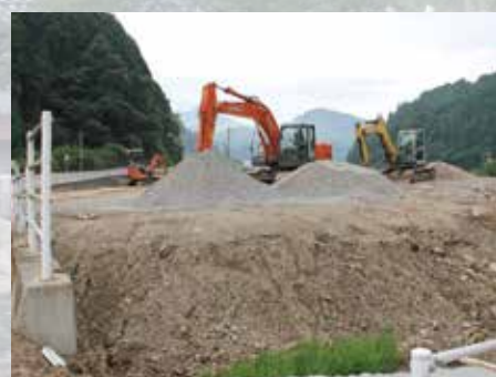
▲災害前は田んぼだった場所が、土地の提供を受け、土砂の運び場となっている(8月14日東峰村)
