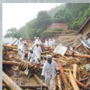
▲土石流で流木が流れこみ建物が倒壊したほうしゅ楽舎(7月7日東峰村)
