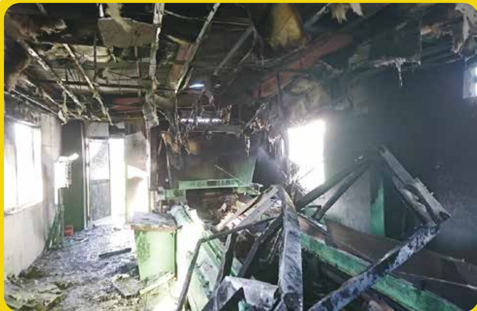
▲リチウムイオン電池の発火が原因で、リサイクル工場の建屋・設備が焼けてしまった事例
