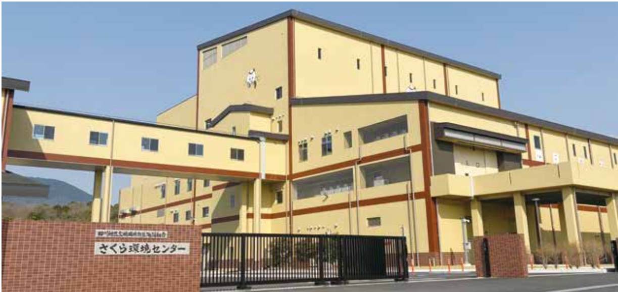
▲4月1日より本格稼働を始めた新ごみ処理施設（さくら環境センター）
