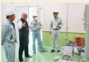
▲「(仮称)埋立処分施設(最終処分場)」にて、工事の進捗状況などを確認の様子
