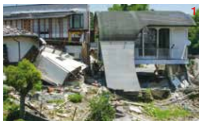
1. 7月6日現在の被災地の様子(西原村) 2. 地震の影響を受けた益城町役場 3. 7月6日現在の地震による家屋の被害(益城町) 4. 現在、早急に取り組まれている仮設住宅(益城町) 5. 復興に向け工事に取り組んでいる様子(益城町)
