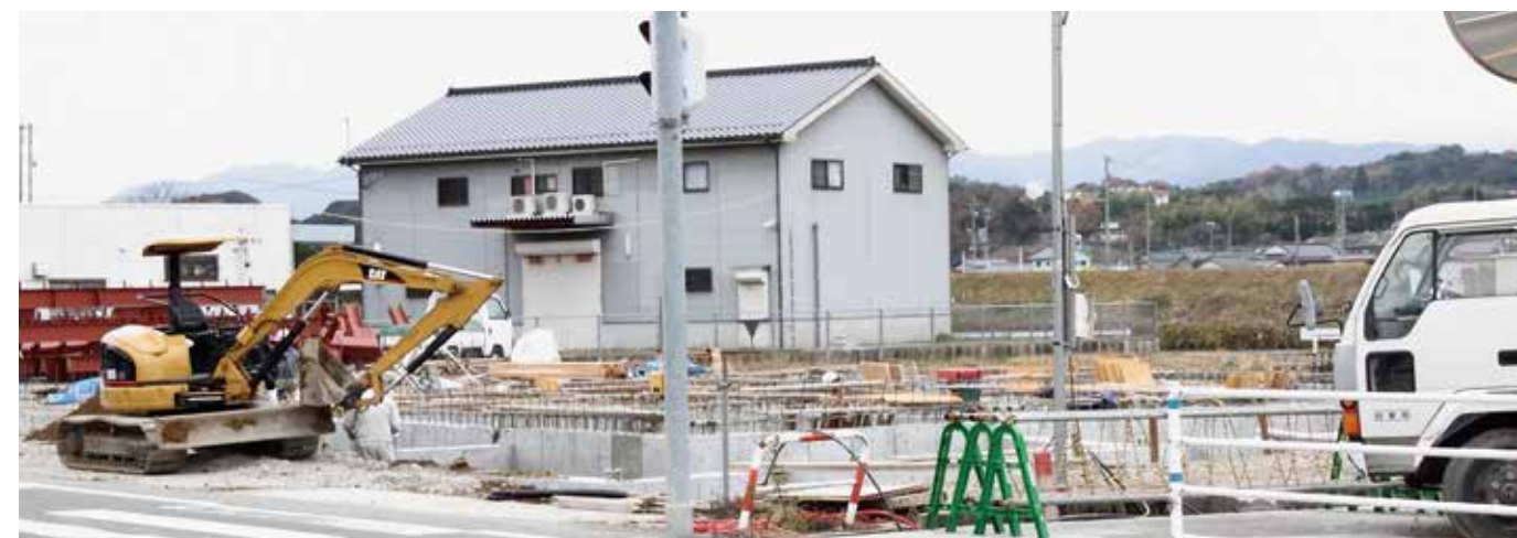
▲町内3小中学校合わせて約500人分の昼食を一気にまかなうために、急ピッチで建設中の給食センター（9月稼働開始予定）
