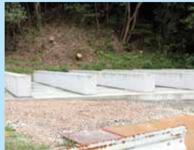
新しくステンレスタンクが設置される基礎
