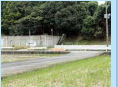
現在稼働中の施設(左)と新設部分の基礎(右)
