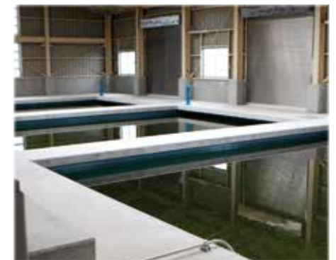
②緩速ろ過地(浄水施設) ろ過砂・ろ過砂利・有孔レンガの順で水を浸透させ、水質の改善を行います。(自然の浄水作用と同様の処理)
