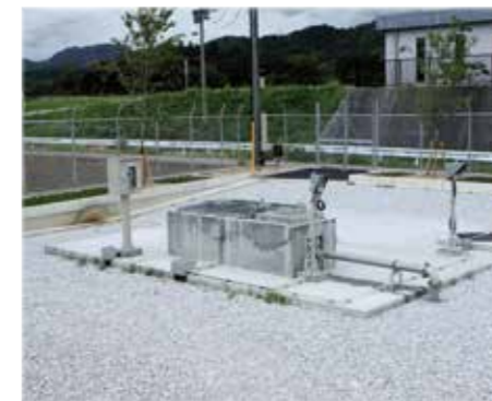
①取水井(取水施設) 地下6mに埋設した多孔形集水管により伏流水を取水し、浅井戸に貯めます。
