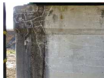
[アルカリ骨材反応の例]
