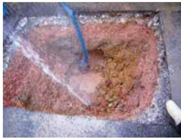
道路に埋設されている町の水道本管の大きさは、50cmから125cmまでで、深さは、道路面から60cmセンチから1m20cmの所に埋設されています。しかし、管が古いと車の通行による振動や水道水の圧力変化などにより水道管にさまざまな影響が出て漏水の原因となっています。
