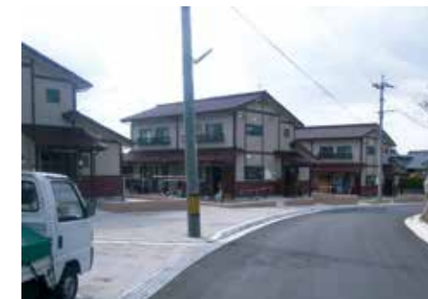
▲町営住宅を建て替えた後の様子(不動)
