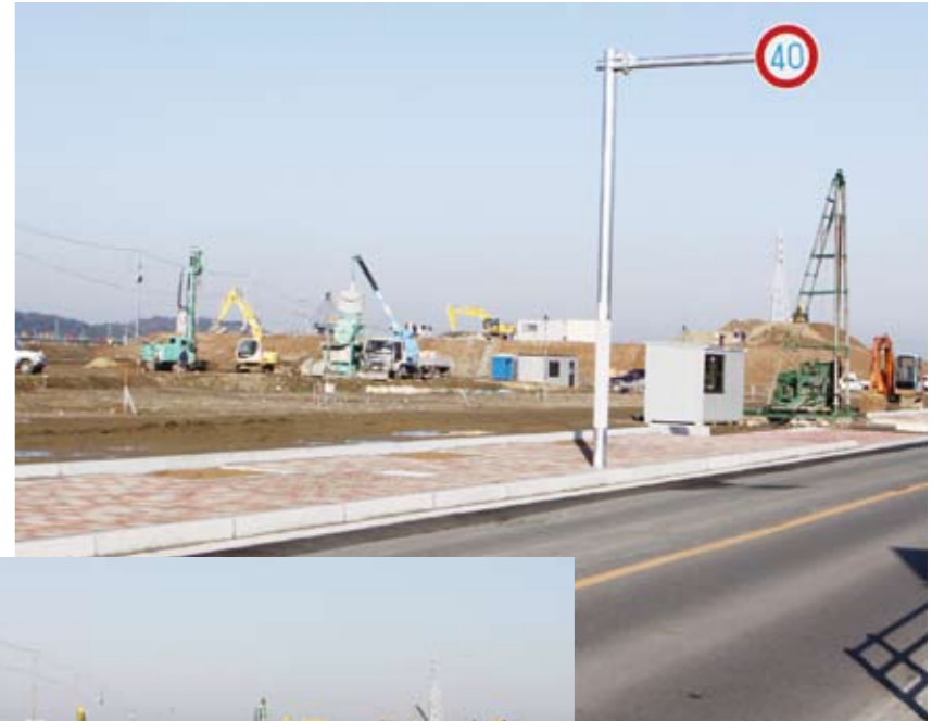
◀▲現在、工事が進められているおおとう桜街道
