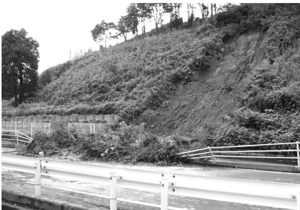
▲7月4日の夜10時頃に、大雨によって地滑りが起きた建徳寺古墳公園横の中央線道路の様子。道路と歩道の間にある鉄製の柵がねじ曲がっているのがわかります。写真は7月5日の朝に撮影
