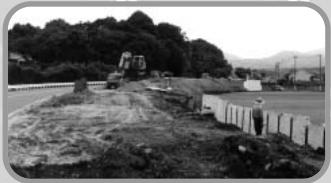
▲ 現在着工中の様子。成光地区の油須宿線跡地を工事中です
