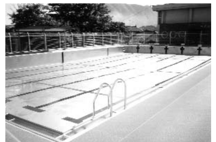
▲ 今任小学校プール新築工事（教育費）
