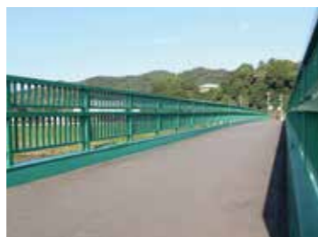
▲改修された島台橋
