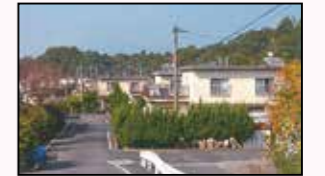
▲森山団地（解体前）
