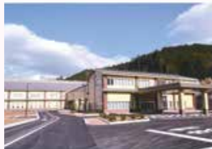
▲田川地区クリーンセンター
